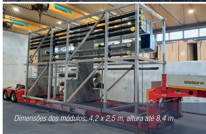
Os módulos foram introduzidos no edifício pelas aberturas com recurso a uma grua.
