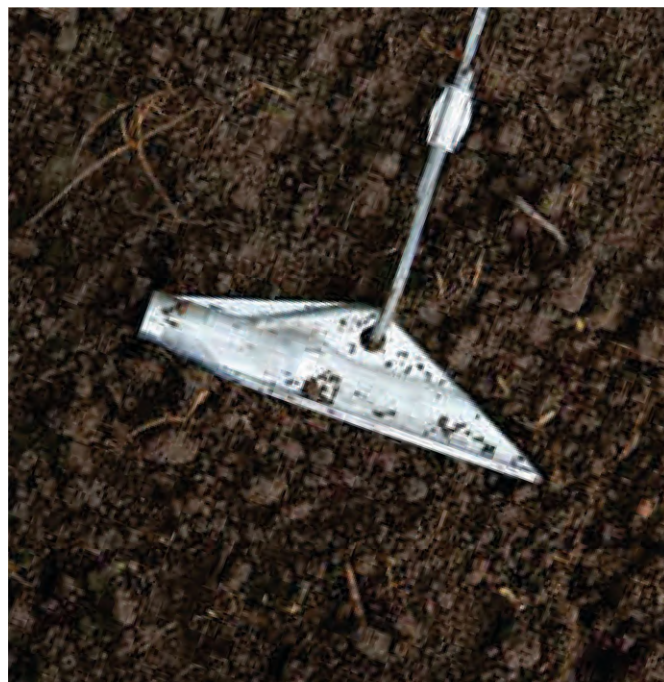
Âncora nº3 instalada e activada.
