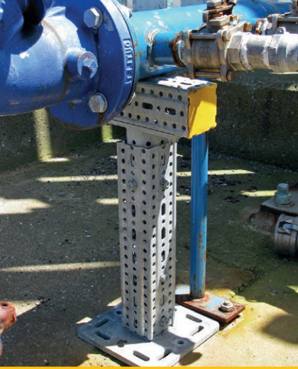
Suportes T convencionais e siFramo 80 poucos meses após a montagem
