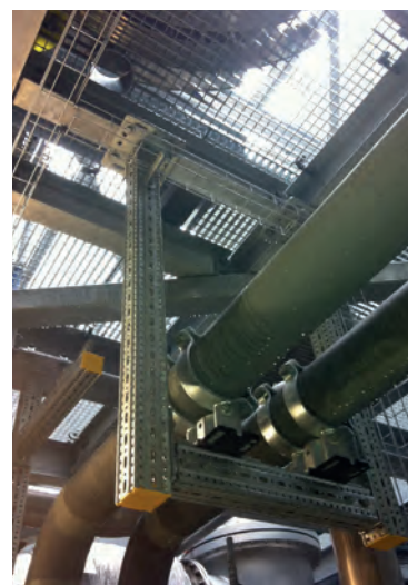
Foto de arquivo: Sistema de aparafusamento modular siFramo para a rápida montagem de construção secundária em aço
